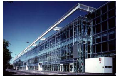
16 Aufzüge, 20 Fahrtreppen, Messe Basel Plus
