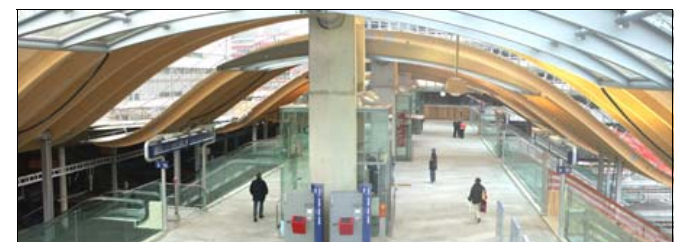
6 Perronaufzüge, 10 Fahrtreppen, SBB Bhf. Bern, Passerelle West
